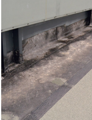
Remontée sur bloc technique
